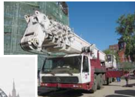
Подготовка к поднятию купола на здание оранжереи
